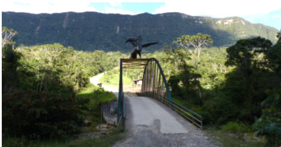
Brücke über den Nangaritzta Fluss in der Cordillera del Condor.
